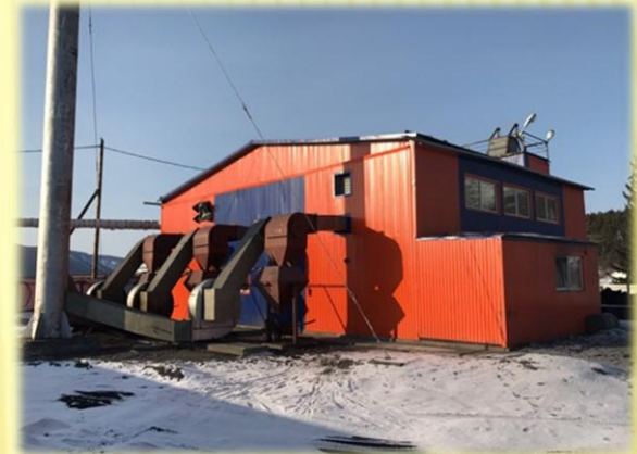
Блочно модульная котельная в п.Перевоз
